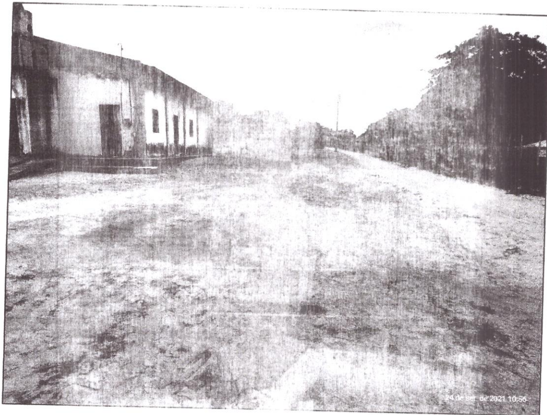
Figura 1 - FACHADA LATERAL DE CASA DE APOIO - UTM 563093.159 / 9495654.985
